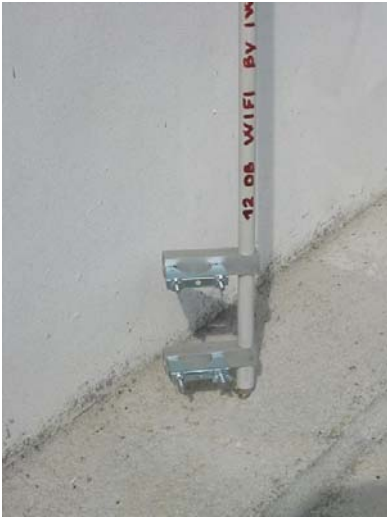
foto del particolare di aggancio al palo o mast, ricavato da due tubolari a sezione quadrata da 2x2 cm. Muniti di gravatte da 40 mm
